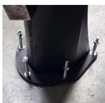
Insérez les goujons dans les pré-perçages aux pieds des boucliers. Vous devez sentir qu'ils traversent la semelle pour aller se loger dans le forage sous le socle. Positionnez ainsi les 5 goujons.
