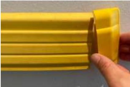
**ETAPE 8 :** Insérer l'embout à chaque extrémité. Vérifier qu'il est bien placé en butée contre le rail et contre la plinthe/lisse.
