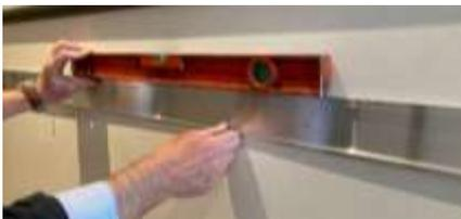
**ETAPE 3 :** Positionner le rail (la lèvre en haut pour la plinthe / les 2 lèvres en haut et en bas pour la lisse, schéma ci-contre). Mettre de niveau et marquer l'emplacement des trous à l'aide d'un crayon.
