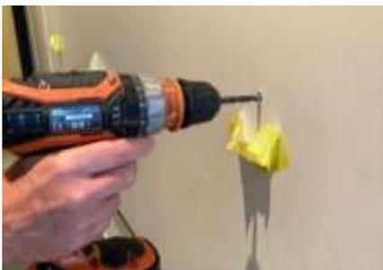
**ETAPE 4 :** Percer le support aux emplacements marqués. Puis insérer les chevilles adaptées au support et aux vis.
