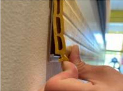
**ETAPE 7 :** Clipser le bas de la plinthe (ou le centre de la lisse) dans le(s) rail(s).
