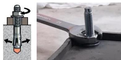
Munissez-vous d'une clé de serrage **17 mm** et serrez au maximum les écrous sur les 4 goujons.
