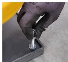
Insérez les goujons dans les pré-perçages au pied du poteau. Vous devez sentir qu'ils traversent la semelle pour aller se loger dans le forage sous le socle. Positionnez ainsi les 4 goujons.
