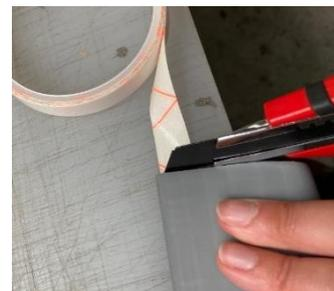
**REMARQUE :** Pour les 4 modèles réf. 601340 (50x50 mm), 601320 (60x60mm) et 601370 (50x50 mm alvéolé) et 601837 positionner une seconde bande d'adhésif pour renforcer l'adhésivage sur chacun des 2 côtés intérieurs.
