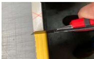
**ETAPE 2 :** Retourner l'Angl'isol® et le positionner sur un angle pour faciliter la découpe. Couper le surplus d'adhésif à l'aide d'un cutter à raz de l'Angl'isol®.
