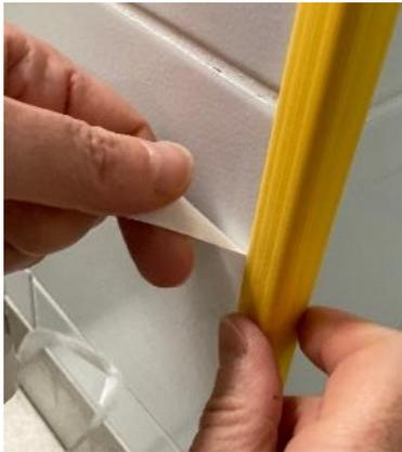
**ETAPE 5 :** Continuer de retirer le protecteur d'un seul côté en maintenant l'Angl'isol® dans sa position définitive car l'adhésif n'est pas repositionnable. Procéder délicatement pour ne pas déchirer le protecteur, si besoin écarter l'Angl'isol® du mur pour faciliter le retrait du protecteur. Puis appuyer sur l'Angl'isol® afin que l'adhésif soit bien en contact avec l'angle à protéger.
