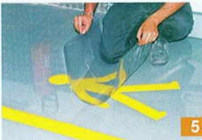
Retirer et conserver le protecteur de l'applicateur. Positionner l'applicateur sur le marquage de façon convexe.
