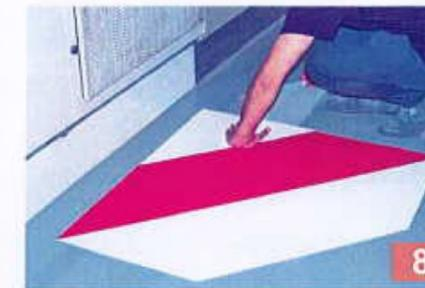
Retirer le protecteur d'un angle. Positionner l'angle bord à bord d'un marquage central de l'autre coloris.
