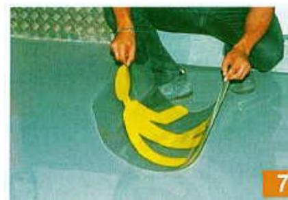
Poser le marquage au sol de façon convexe pour chasser l'air vers l'extérieur. Appliquer une légère pression avec la main.
