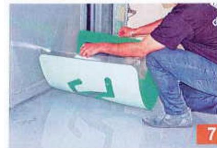
Poser le marquage au sol de façon convexe pour chasser l'air vers l'extérieur. Appliquer une légère pression avec la main.
