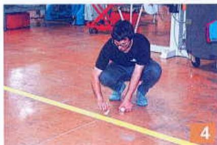
Tracer une ligne continue avec la ficelle en l'accrochant d'un bout à l'autre (ex : avec un adhésif au sol).
