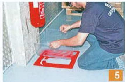
Retirer et conserver le protecteur de l'applicateur. Positionner l'applicateur sur le marquage de façon convexe.
