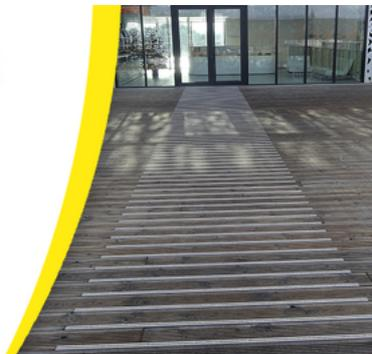
Le nez de marche plat minéral est constitué de résine et de granulats de marbre offrant une excellente résistance à la glissance, notamment en environnement humide. L'angle d'attaque de son profilé est optimisé ( $< 30^\circ$ ) pour ne pas être accidentogène. La surface antidérapante contrastée est de 3 cm ou 5 cm.
